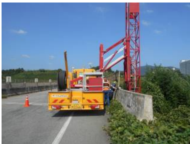
점검차량을 이용한 외관조사
